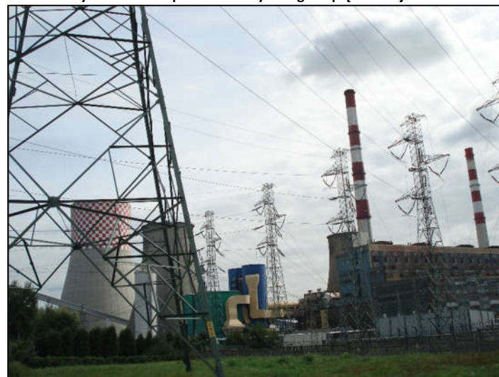
Fot. 4 Elektrownia Łagisza.
