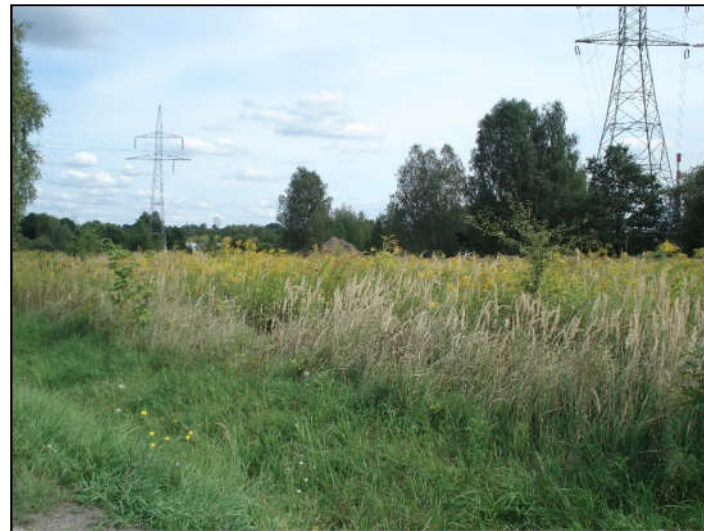
Fot. 3 Nieużytki ruderalne pod liniami wysokiego napięcia w rejonie ul. Odrodzenia.
