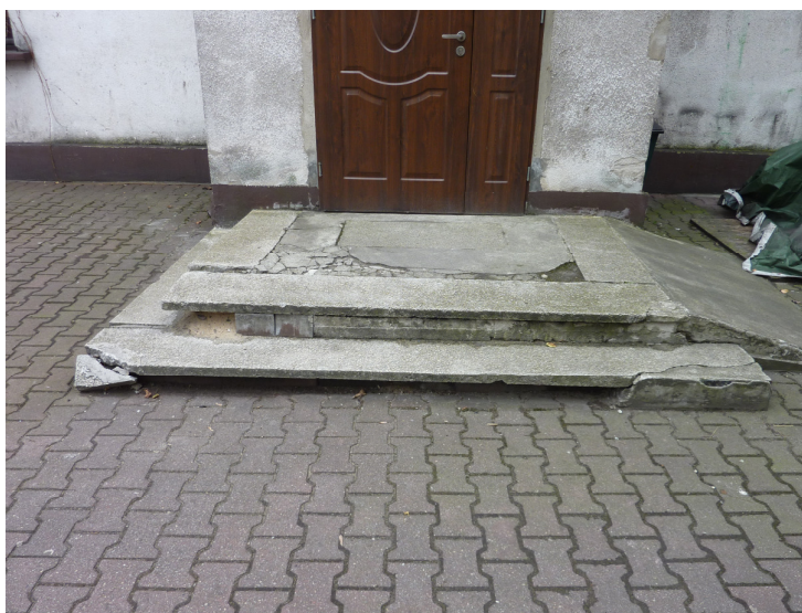
widok przewidzianego do remontu wejścia do budynku
